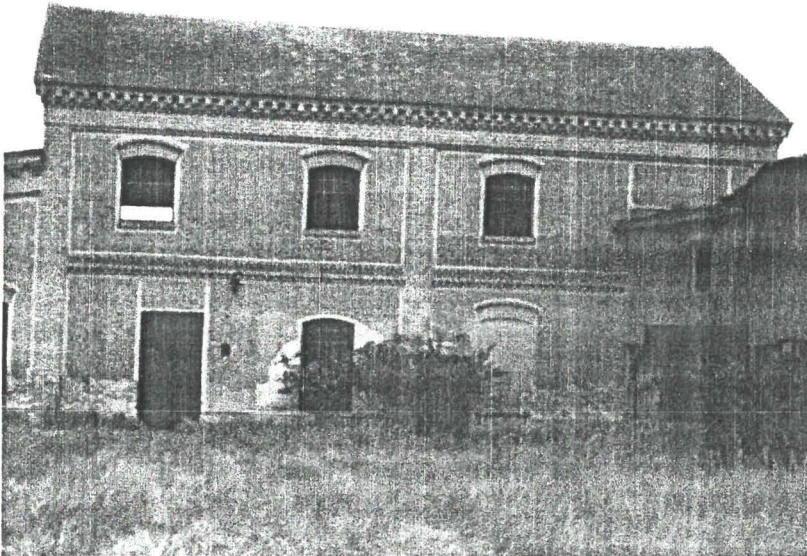
Abbildung 114 - Ziegelwerk Zistersdorf, Maschinenhaus
