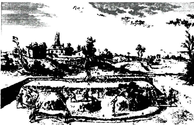
Abbildung 16 - Rohmaterialaufbereitung in einer Feldziegelei des 18. Jahrhunderts, Kupferstich, 1763
