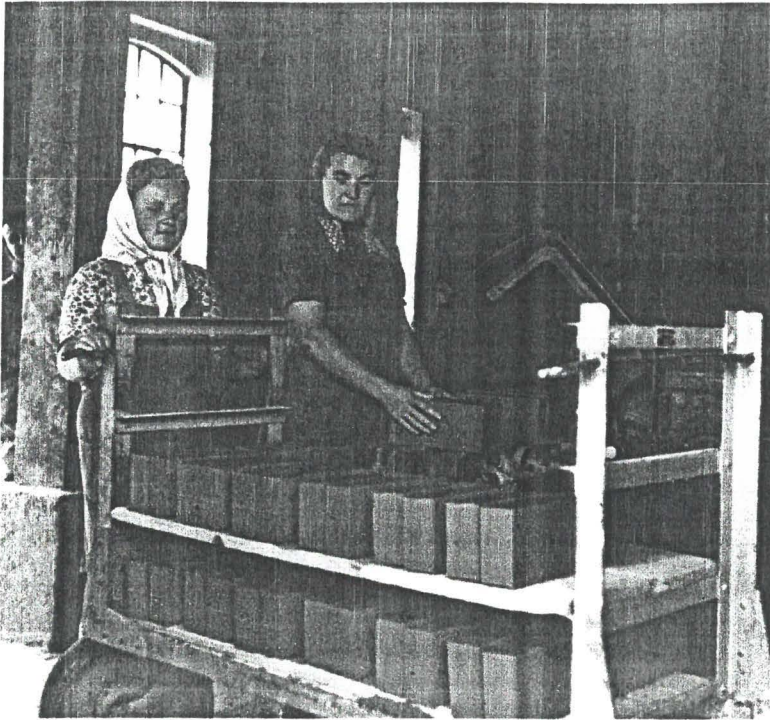
Abbildung 23 - Frauen beim Abschneider, im Hintergrund Strangpresse
