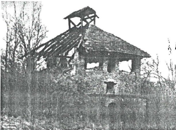
Abbildung 116 - Ziegelwerk St. Michael, Ringofen
